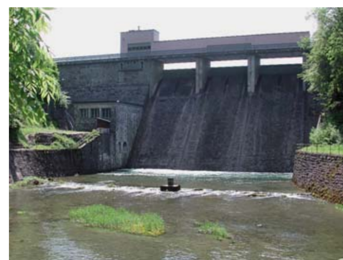
Wehrüberlauf in den Schlagen
